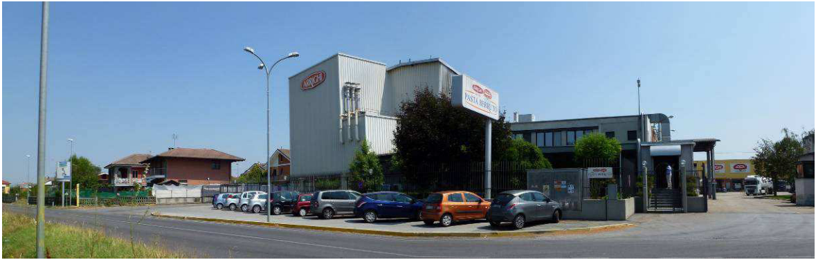
1 📍 Vista dello stabilimento su Via Sommariva
