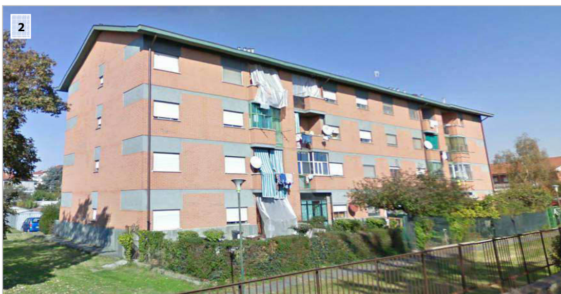
Vedute dell'area e del fabbricato (da Google Maps – Street View).
