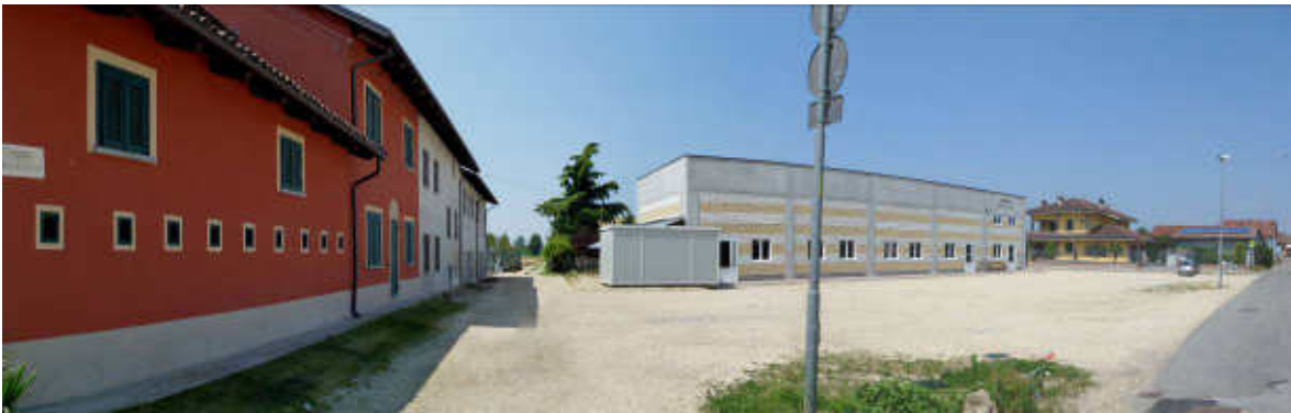
6 📍 Il breve tracciato di Via Montecucco, a Est dello stabilimento
