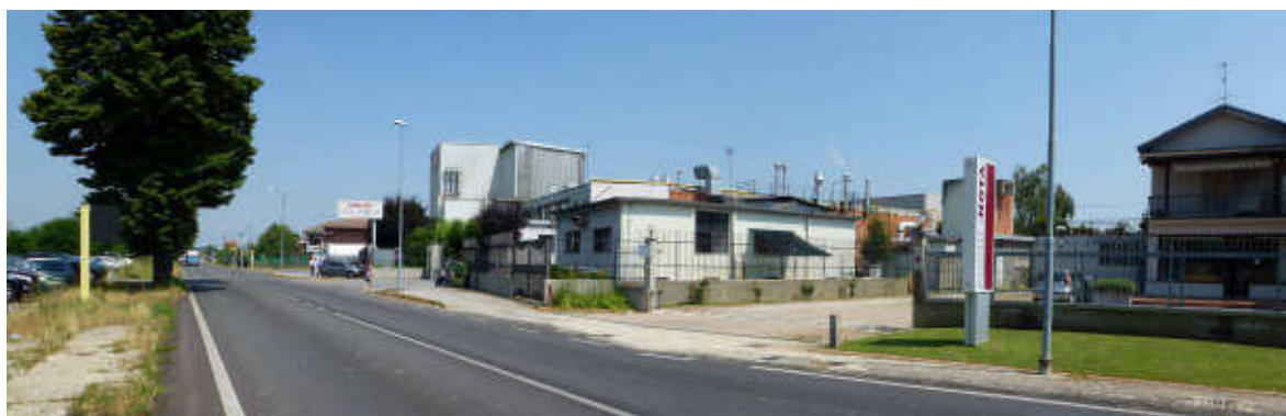
2 📍 Via Sommariva in direzione Nord, nei pressi dell'accesso allo stabilimento
