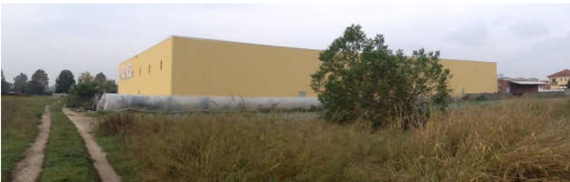
8 📍 L'attuale sezione di immagazzinamento dello stabilimento
